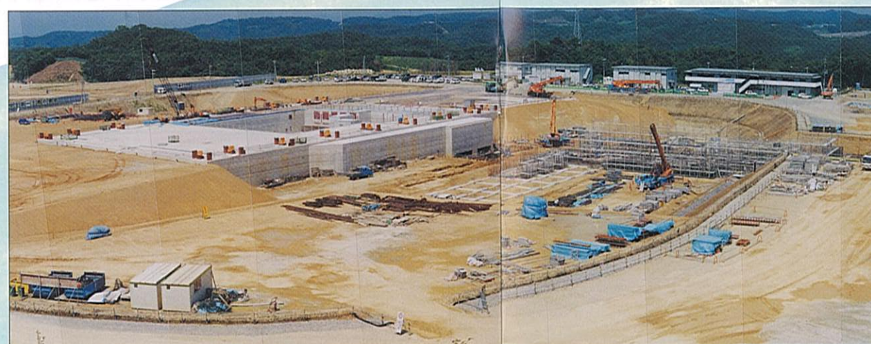
工事現場全景 (平成13年8月23日撮影)
