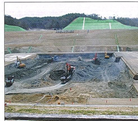
震動台基礎掘削 (平成12年4月7日撮影)
