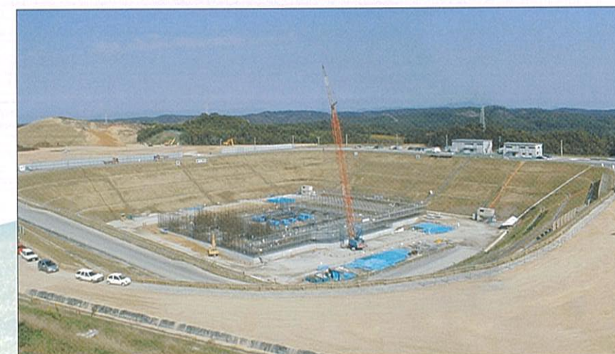
工事現場全景 / 天端 -18mリフト (平成12年10月19日撮影)
