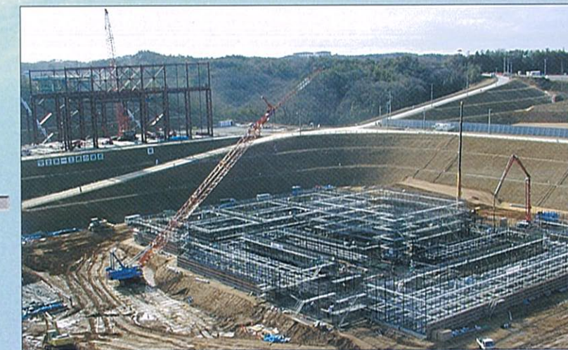
コンクリート打設・鉄筋組立 / 天端 -12mリフト (平成13年1月10日撮影) 後方は実験準備棟建築工事
