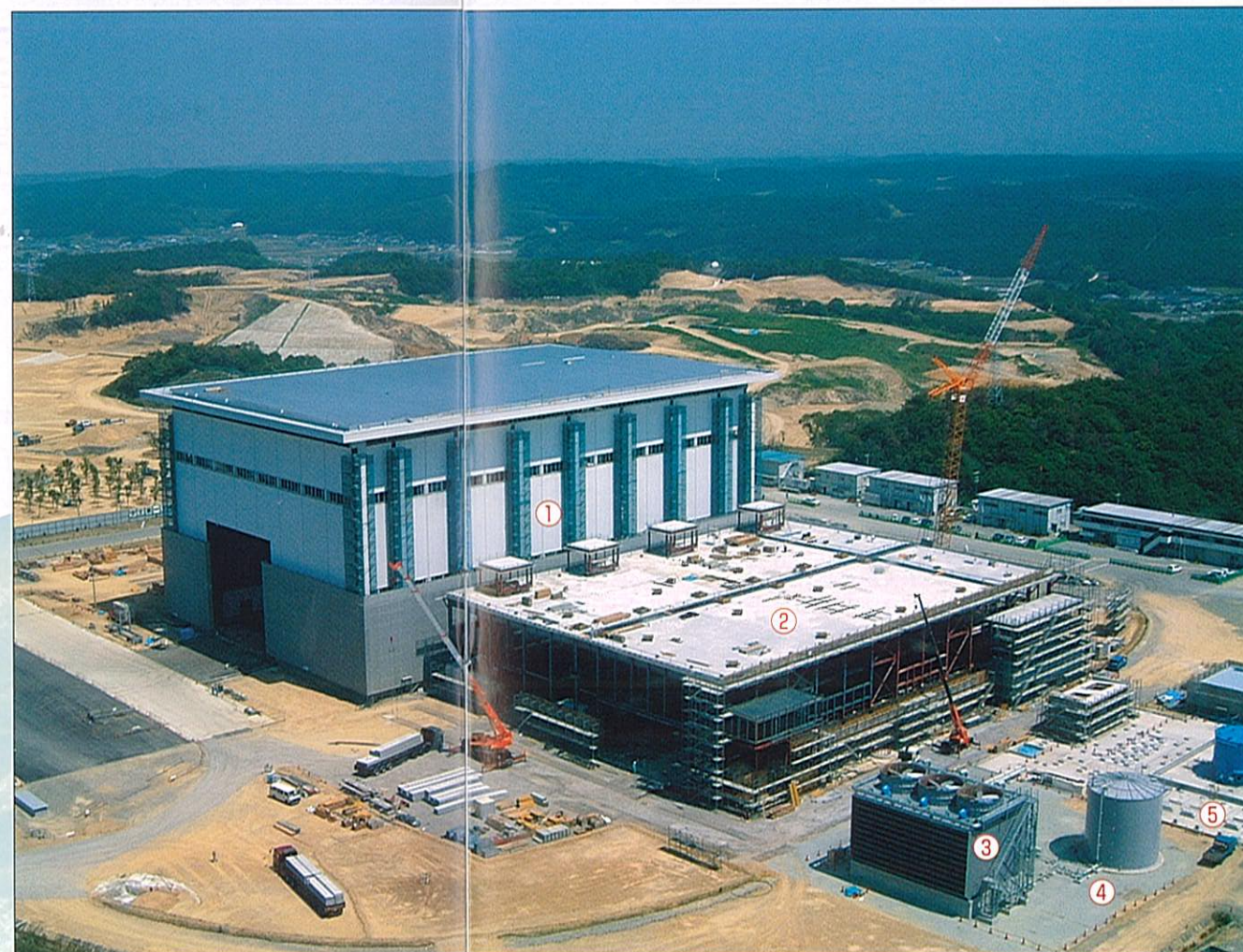
工事現場全景 (平成14年6月6日 兵庫県撮影)
