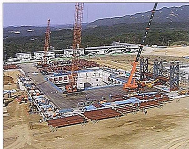
実験棟建築工事 (平成13年9月20日建方開始)
