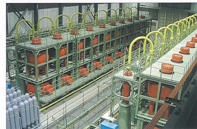
主アキュムレータ (平成15年3月撮影) 主仕様 ① 20基装備 ② 蓄圧能力：1000L/基 (20.6Mpa)
