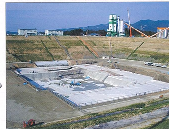
震動台基礎 捨コンクリート (平成12年5月18日撮影)
