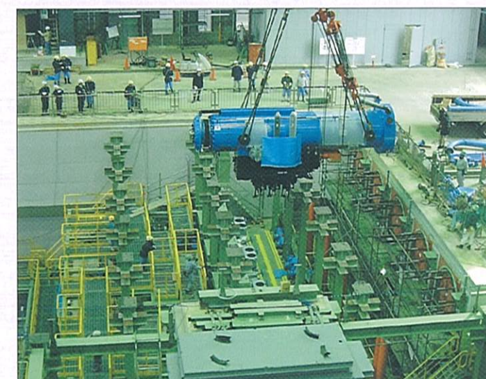
水平加振機据付状況 (平成14年12月撮影)
