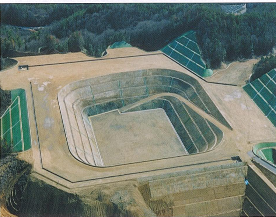
建設用地造成全景 (平成12年1月17日撮影)
