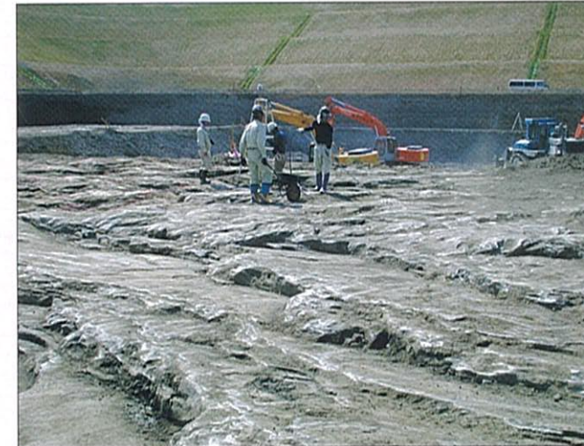
震動台基礎岩盤 (平成12年4月18日撮影) 造成底地面から深層部で約7mで神戸層に岩着
