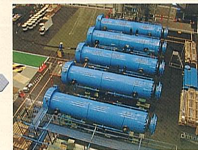
水平加振機組立完了 (平成14年1月17日撮影)
