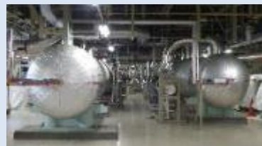
高圧第1、2給水加熱器（解体撤去前）
