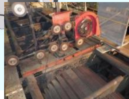
ワイヤーソーを使った冷却管群の一括切断
