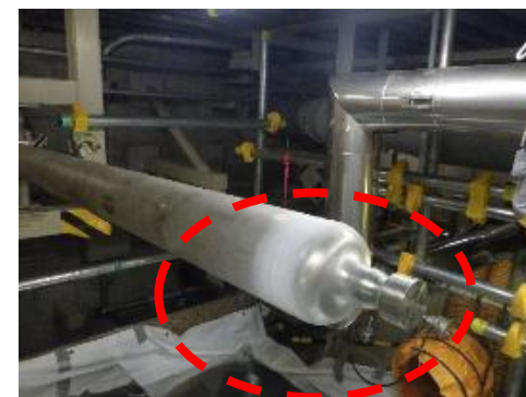
隔離作業後（中間熱交換器入口配管）
