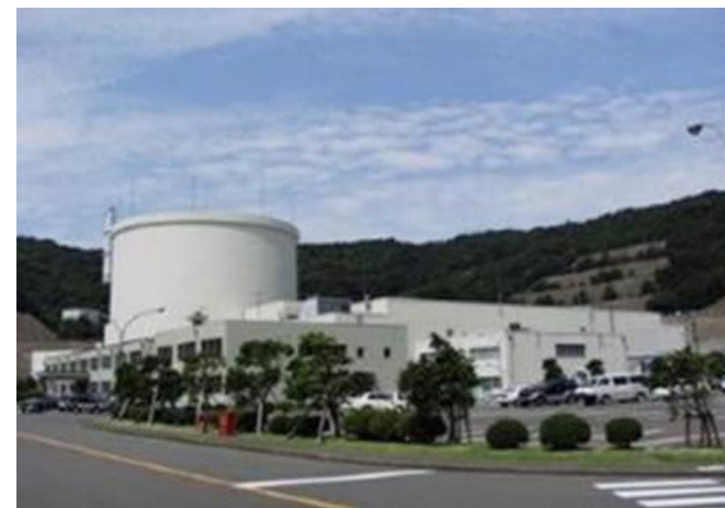
新型転換炉原型炉ふげん 平成20(2008)年2月12日廃止措置計画認可
