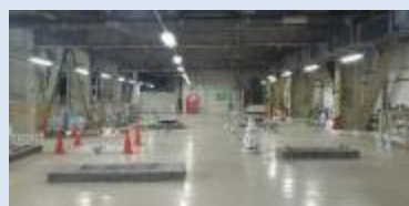
高圧第1、2給水加熱器（解体撤去後）
