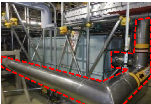
予熱・保温設備（解体前）
