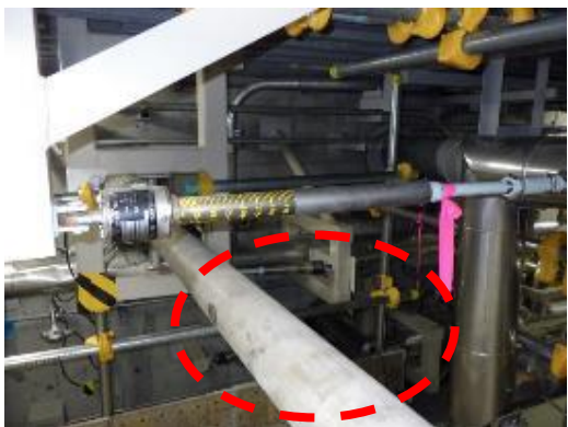
隔離作業前（中間熱交換器入口配管）
