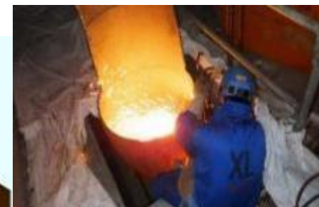
高圧タービン排気配管の切断
