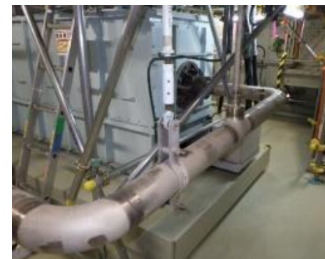
予熱・保温設備（解体後）
