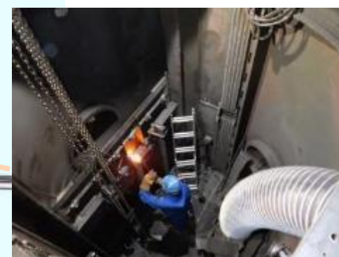
湿分分離器内部構造物の切断
