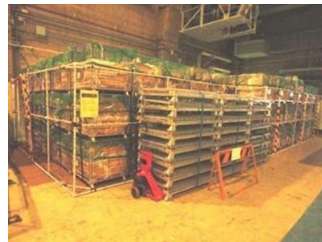
「ふげん」のクリアランス測定待ちの解体廃棄物
