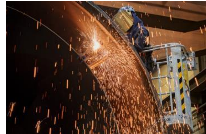
切断(ホットカッティング)
