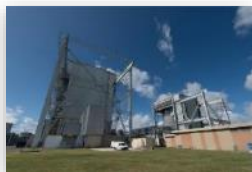
Saint Laurent 2 基 UNGG 1969-1990 et 1971-1992 廃止措置命令: 2010年
