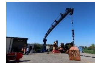
蒸気発生器(SG)取り 外し用の主要な補助 ハンドリングシステ ムの供給および設置
