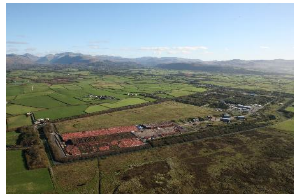
低レベル放射性廃棄物処分場
