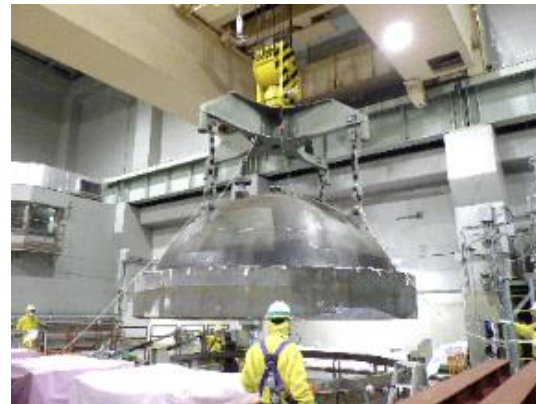
圧力容器上蓋 取り外し
