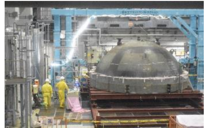
大型バンドソーによる切断作業
