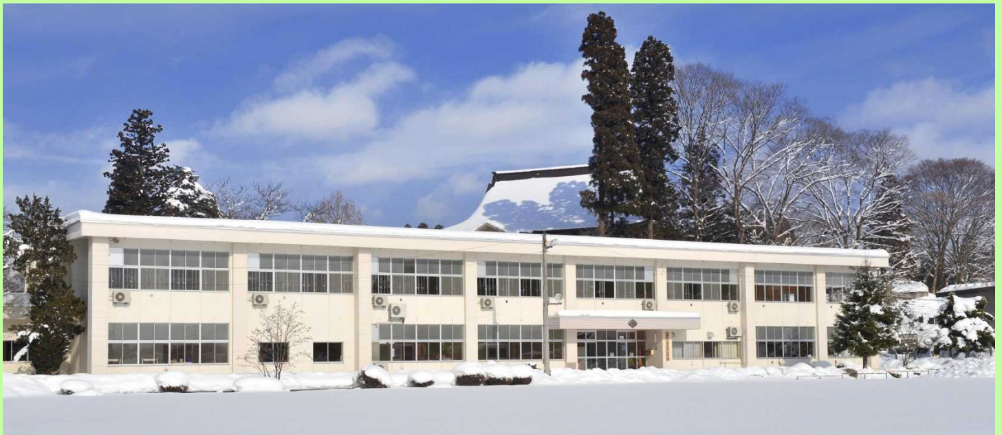
白神フーズ(株)生ハム工場 秋田県 大館市 旧山田小学校
