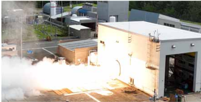
異常発生直前(南側)
