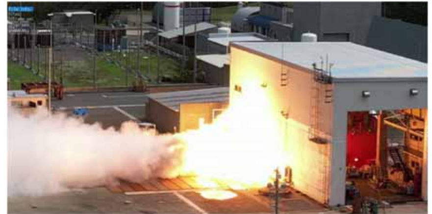
異常発生直後(南側)
