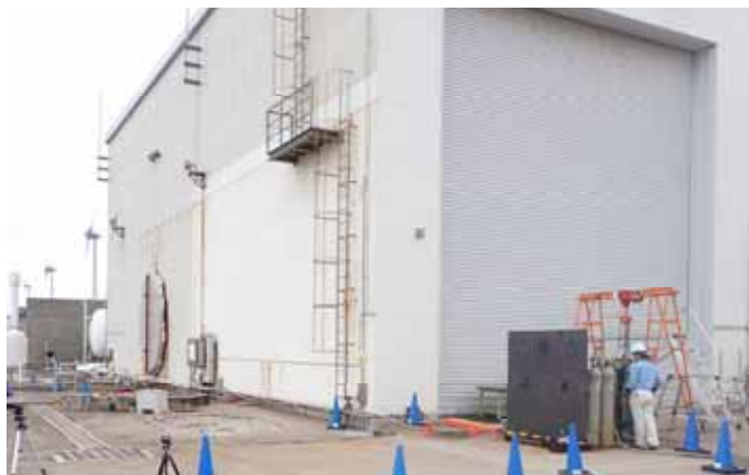
真空燃焼試験棟(燃焼前)
