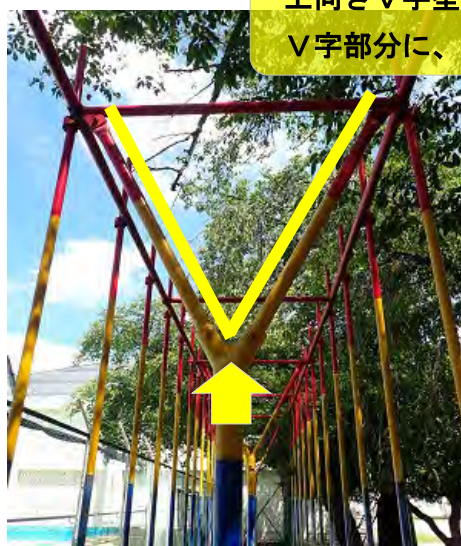
写真 29 写真 28 に点検箇所を例示
