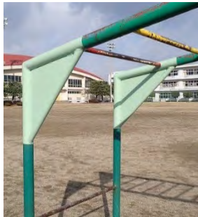
写真30 開口部を全て埋めた対策例
