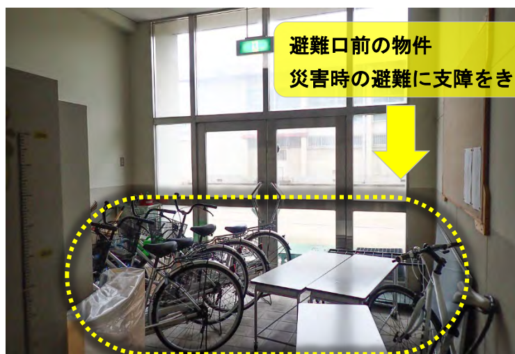
写真 27 写真 26 に点検箇所を例示
