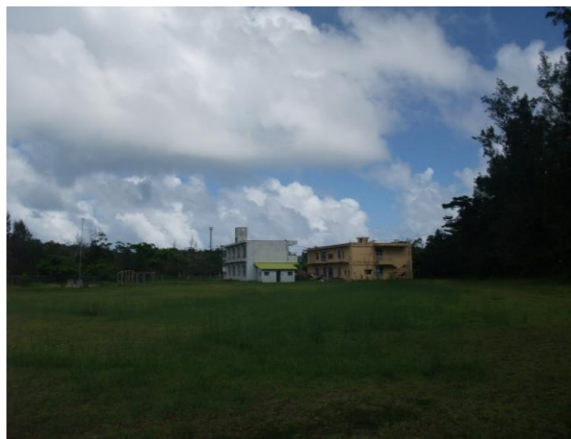
校舎等の外観写真
