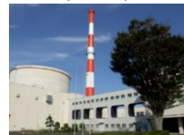
高速実験炉「常陽」
