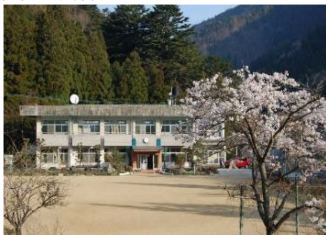
校舎等の外観写真
