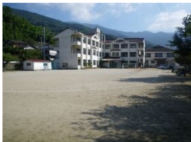
校舎等の外観写真
