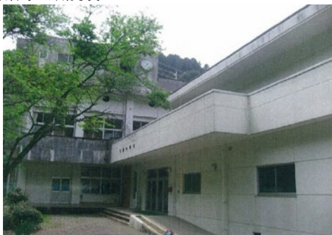
校舎等の外観写真
