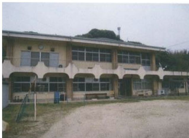
校舎等の外観写真
