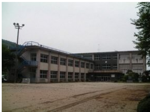
校舎等の外観写真
