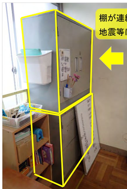
写真 19 写真 18 に点検箇所を例示
