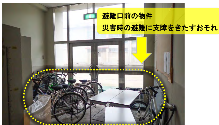
写真 27 写真 26 に点検箇所を例示
