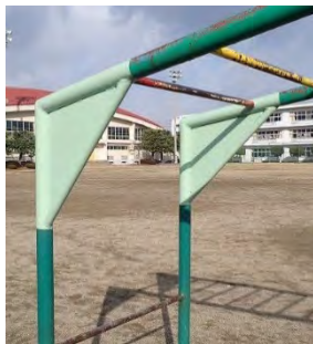
写真 30 開口部を全て埋めた対策例
