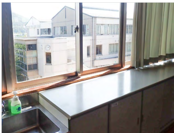
写真1 転落の危険のある窓（学校A）
