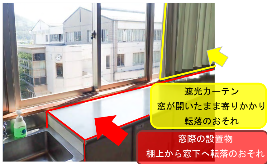
写真2 写真1に点検箇所を例示
