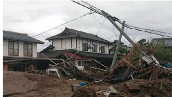
令和元年東日本台風の被害(長野県の土砂災害)
