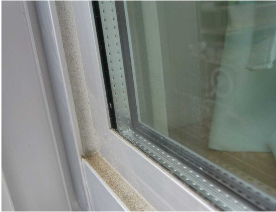
複層ガラスの設置（新潟県長岡市立新町小学校）
