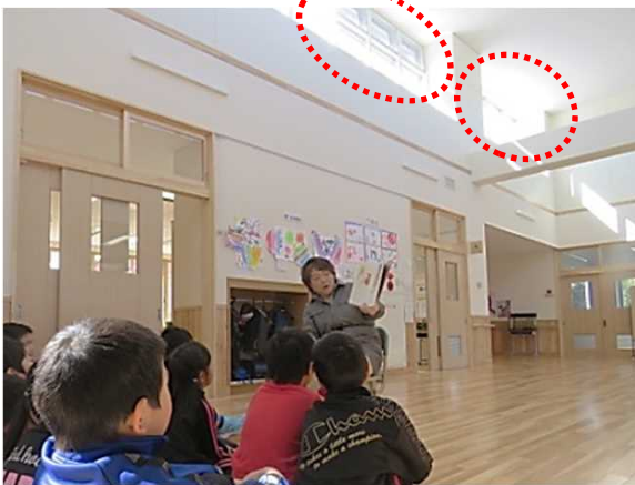
晴天時はハイサイドライト（高窓）による自然光だけで読み聞かせが可能（北海道南富良野町立南富良野西小学校）
