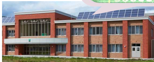
校舎屋上には太陽光パネルを、校舎内には発電量を確認できる大型パネルを設置 (北海道南富良野町立南富良野小学校)
