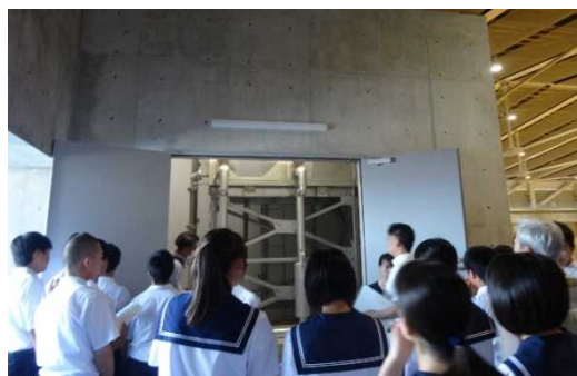
井水利用設備を見学する生徒の様子
