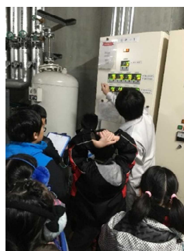
チップボイラーの見学
