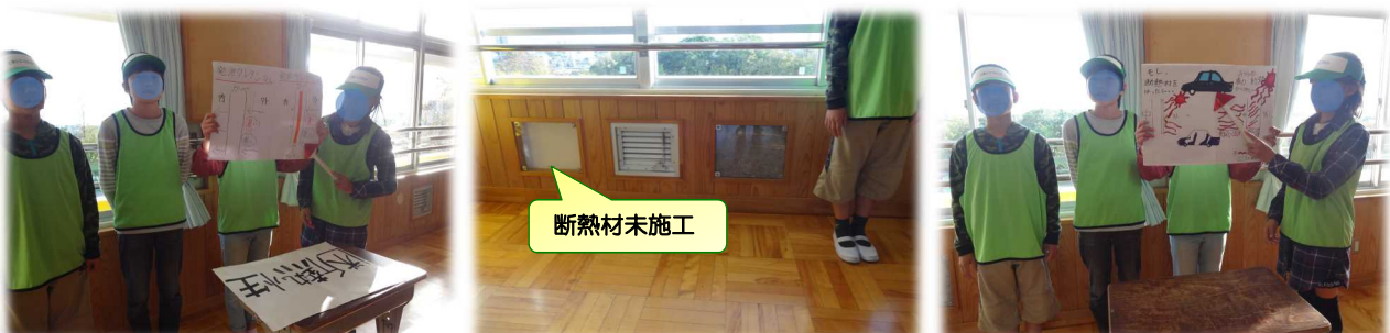
断熱材 一部に断熱材未施工部分が残っており、断熱材の効果を実際に体感出来る仕組みを利用しながら、断熱材の機能・役割を説明してくれました。
