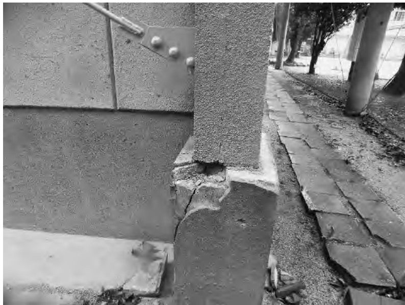
写真 4.5 耐震補強済みの体育館で発生した露出型柱脚における側方破壊
