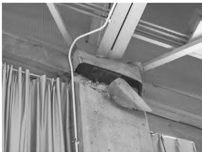
写真 4.1 定着部における側方破壊の例
