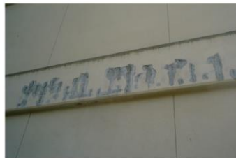
梁コンクリートの剥落 鉄筋の露出
