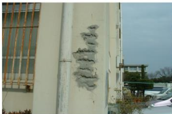
柱コンクリートの剥落 鉄筋の露出
