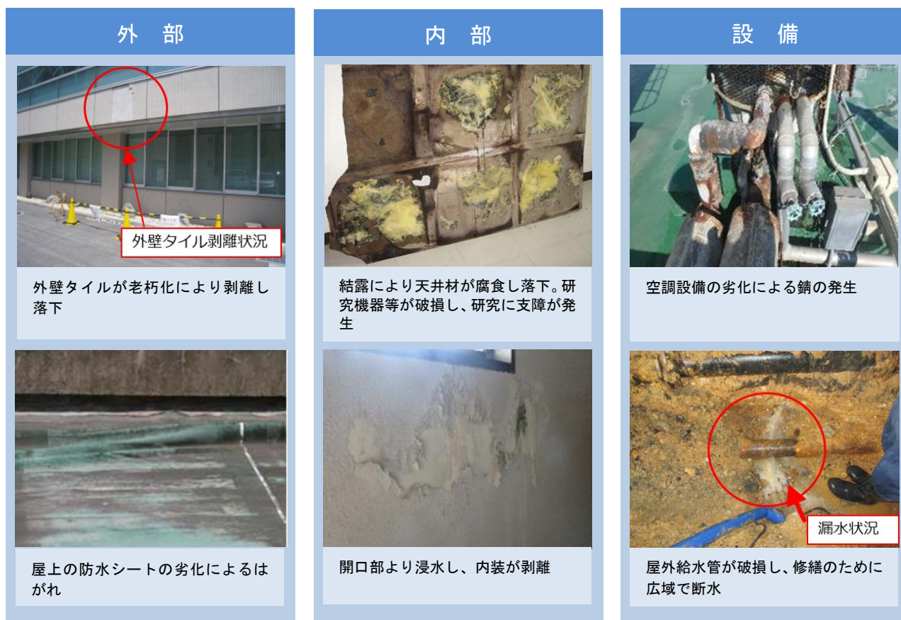
図4 施設・設備の老朽化の状況
