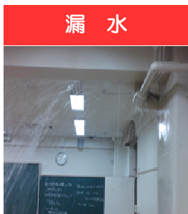
■給水管 経年47年 劣化した配管から漏水し、断水。
