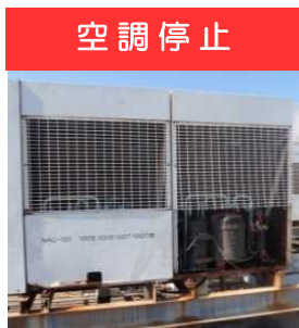
■空調機 経年26年 内部部品が腐食したため、温度調節が出来ない状態。
