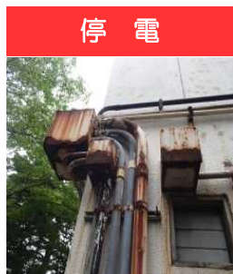
■分電盤 経年50年 電気配線の老朽化による断線のため、停電。
