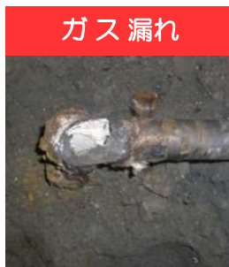
■ガス管 経年33年 ガス配管老朽化によりガス漏れが生じたため、停止。
