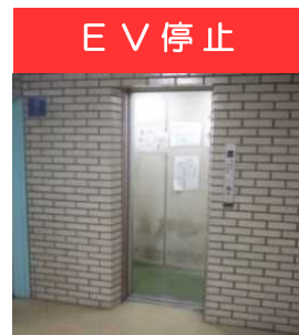
■EV 経年35年 故障により閉じ込め事故発生。
