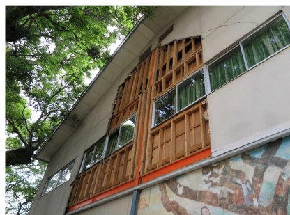
<経年劣化したラスモルタルによる外壁（湿式外壁）の落下（体育館）>
