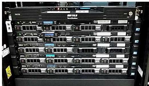
システム用サーバ機器
