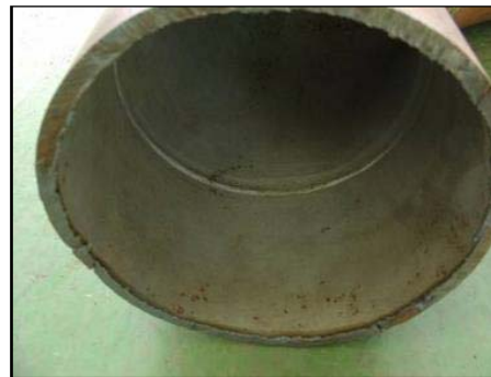
「常陽」MK-III改造工事で切断した主中間熱交換器2次側出口エルボ
