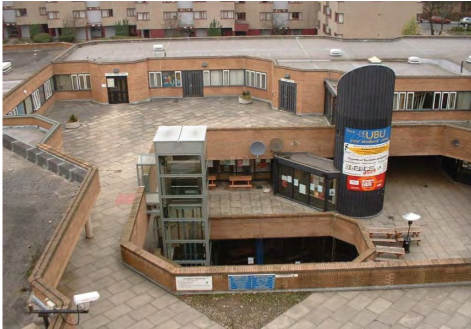
古い建物の中庭を改修して内部化
