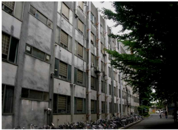
老朽施設の外観(築48年)(東工大)
