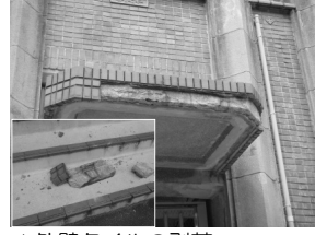
▲外壁タイルの剥落
