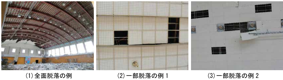
写真1 天井の震動被害の例
