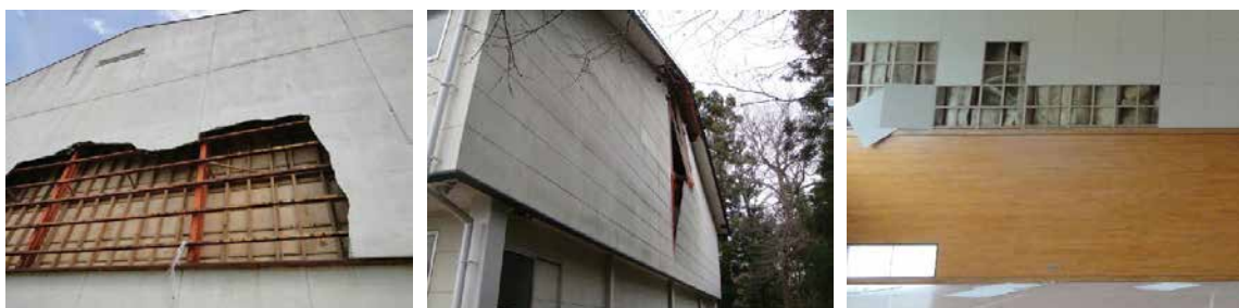
(1) 外壁(ラスシート)脱落
