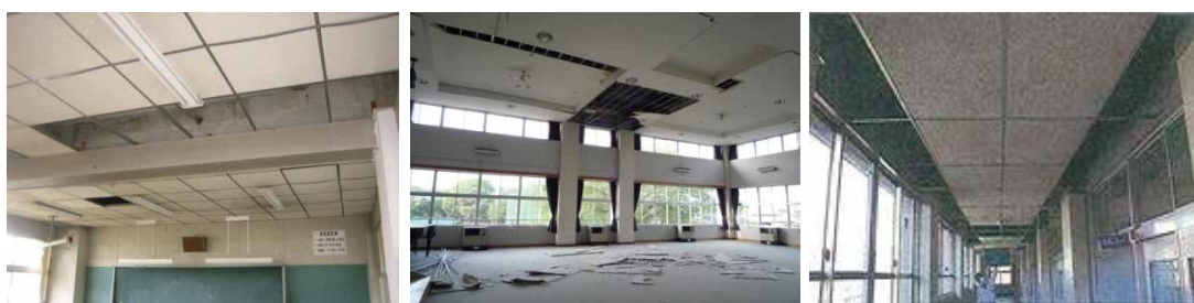
(1) 普通教室の天井脱落
