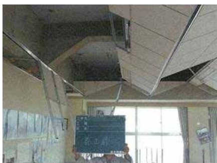
(1) 音楽室の折れ曲がり天井脱落
