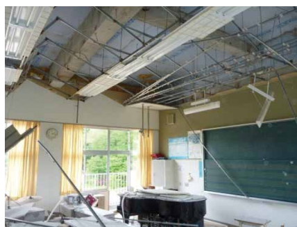
(2) 音楽室の折れ曲がり天井脱落
