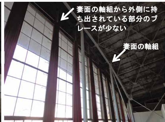
写真 30 妻面の開口部の屋根ブレース
