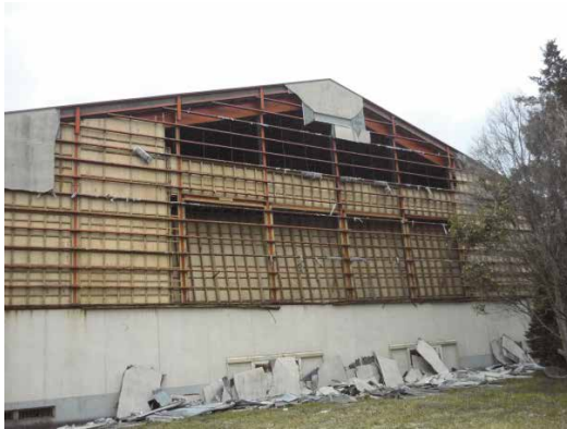
写真 35 外壁妻面のラスシートの全面脱落
