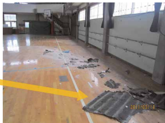
写真45 脱落したモルタル
