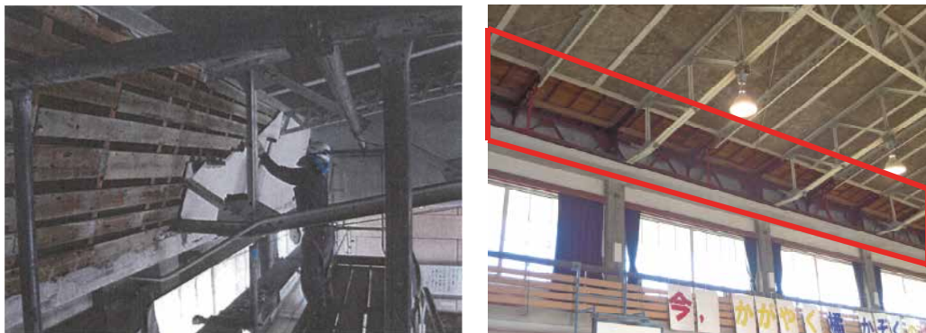
写真 50 既存のモルタル下がり壁を下地から撤去した事例
