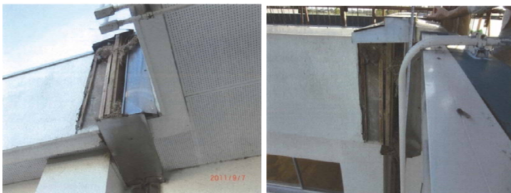
写真28 エキспанション・ジョイントカバーの脱落
