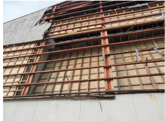
写真 36 取付け部の状態
