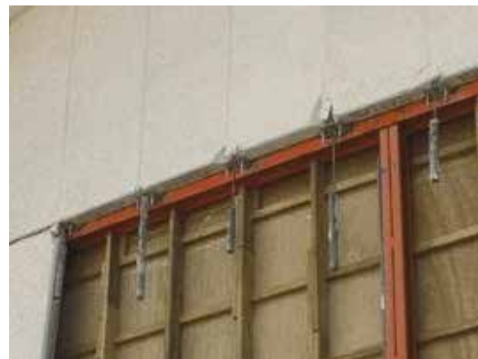
写真 38 取付け部の状態
