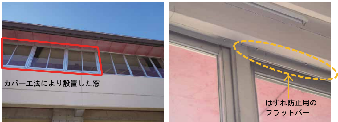
写真 48 カバー工法により既存枠に新設枠を設置し復旧した事例 (枠上部にはずれ防止用のフラットバーも設置)
