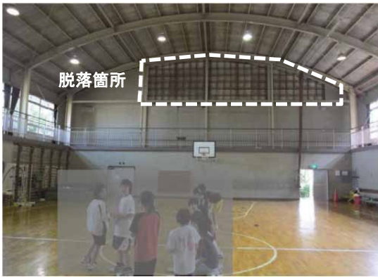
写真41 内壁妻面(有孔ベニヤ板)の大規模脱落
