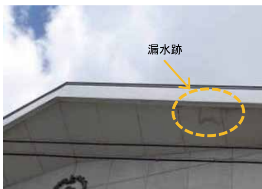
写真 51 軒天井の漏水跡の例
