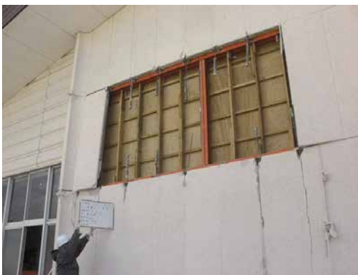
写真 37 妻壁の ALC パネル(縦壁挿入筋構法)の脱落
