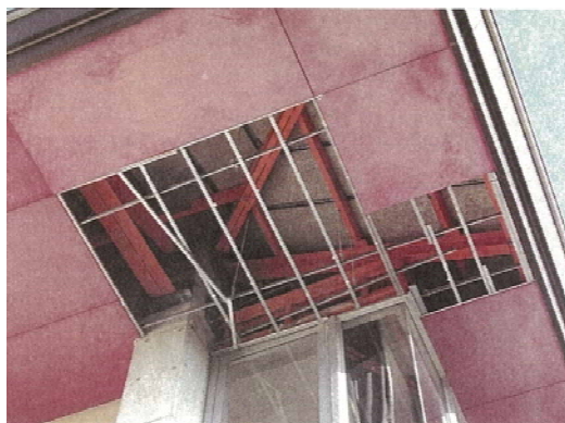
写真 46 軒天井の脱落
