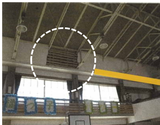
写真44 内壁モルタルの脱落
