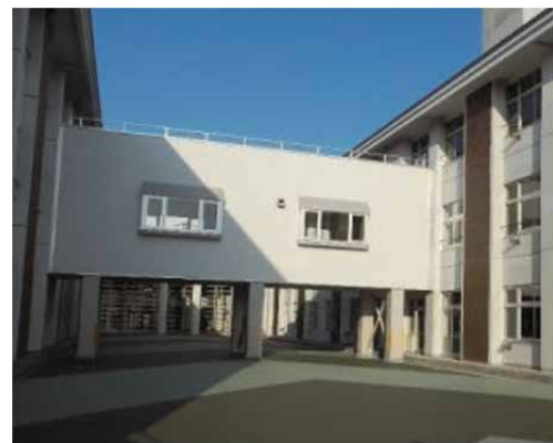
写真 47 地震被害への復旧対策の例
