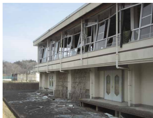
写真 34 横連窓の大規模な脱落・損傷（北面）
