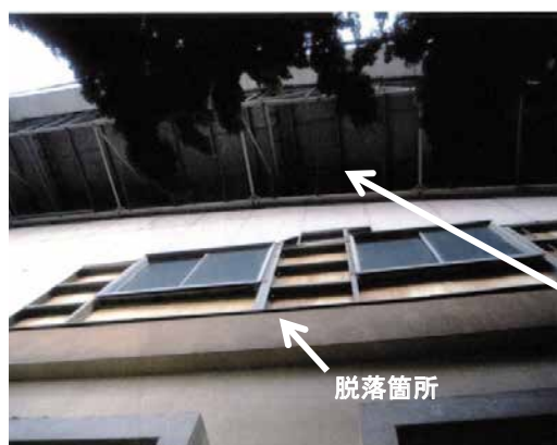
写真 39 外装材（フレキシブルボード等）の脱落
