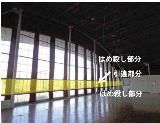
写真 29 妻面の開口部（復旧後）
