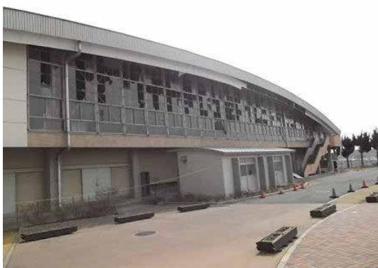
写真 31 桁行面の開口部の被害
