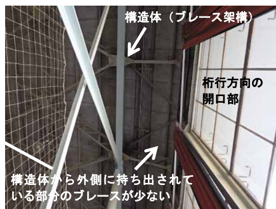
写真 40 桁行方向の開口部の屋根ブレース ※全景写真は 2-3-1 参照
