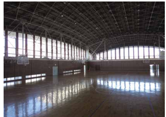
写真 32 張間方向・桁行方向のブレース（復旧後）
