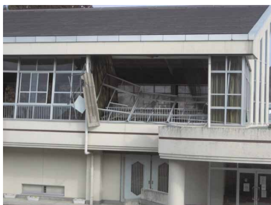
写真 33 横連窓の大規模な脱落・損傷（南面）
