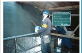
(下) 鉄筋コンクリートの長寿命化工事 (中性化対策)
