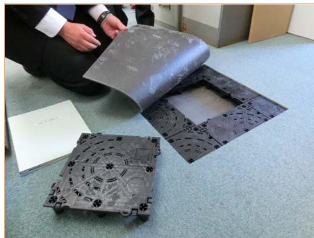
写真②：人の通行等の支障にならないよう、OAフロアを整備。
