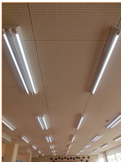
写真①： 隣接する普通教室への音の伝搬に配慮し、天井部分に吸音材を整備した多目的室。
