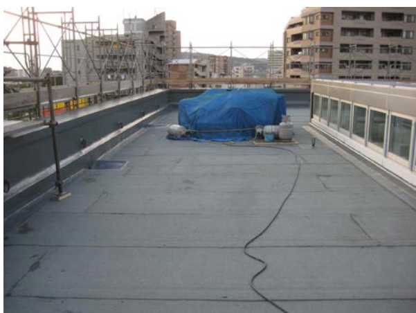
図1 撤去工法によるアスファルト防水（施工後）
