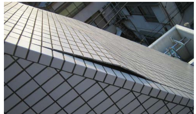
写真4 タイルの浮き・はく離
