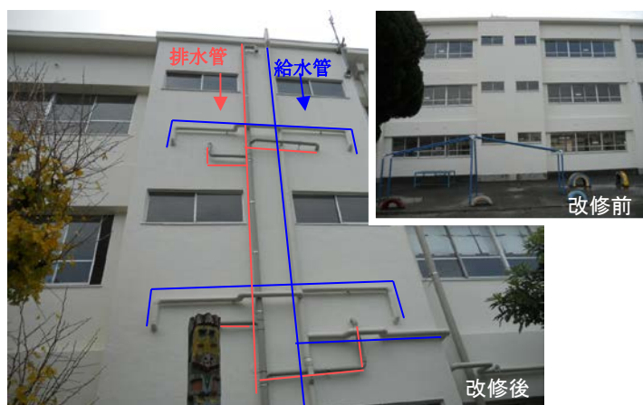
配管の露出化により維持管理の容易性を確保しつつ、廊下流しの配管を新しい配管に取り換えた例
