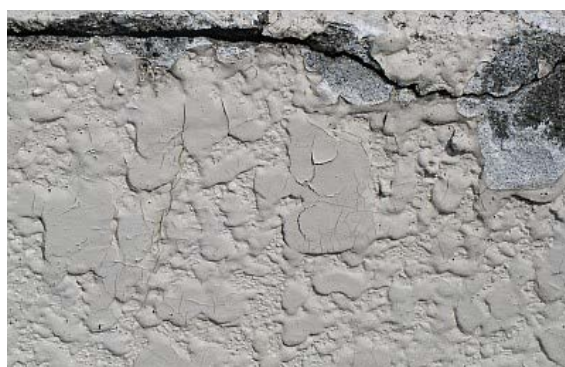
写真2 塗膜のひび割れ
