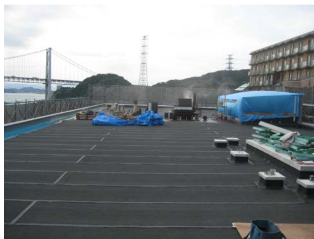
図4 撤去工法による改質アスファルト防水（施工後）
