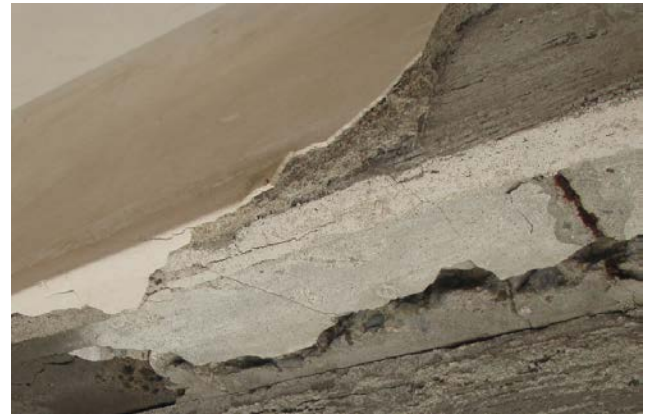
写真3 モルタルの浮き・はく離
