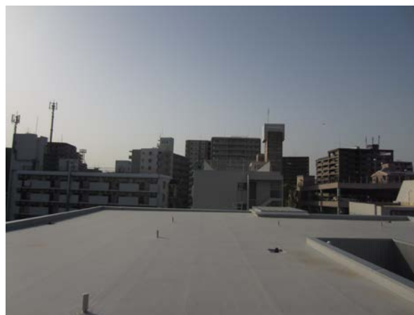
図2 かぶせ工法によるシート防水（施工後）
