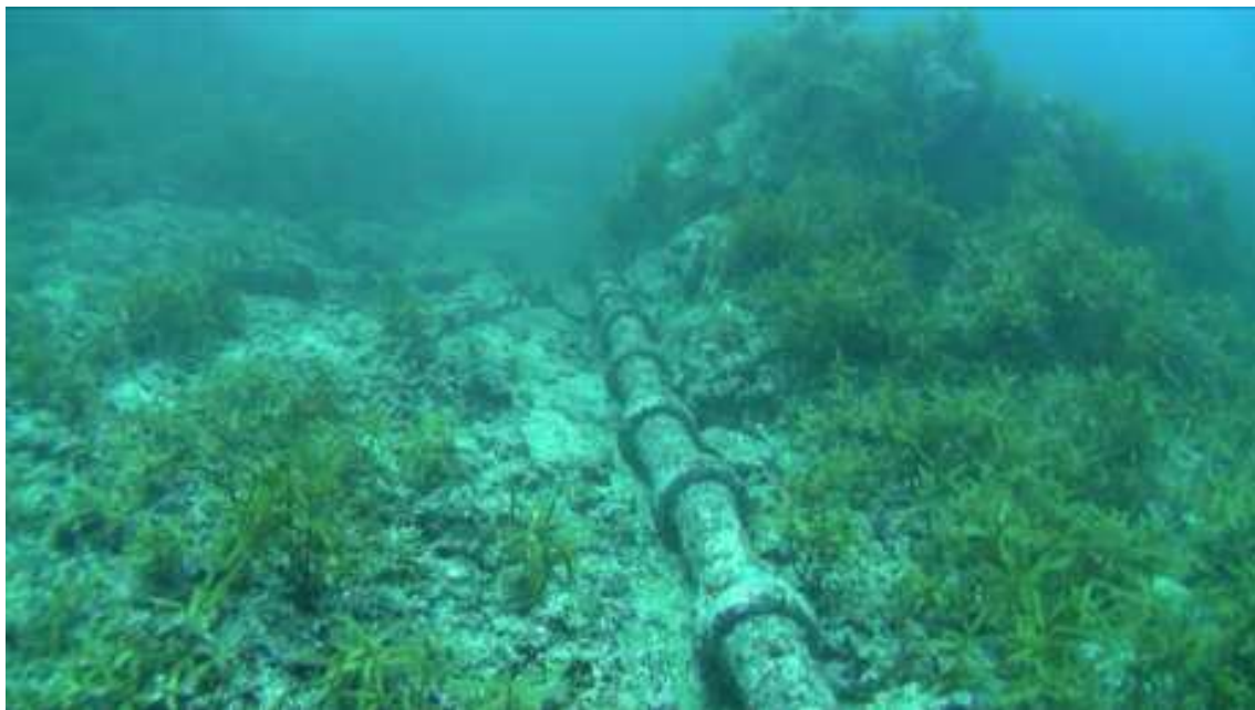
図 2 . 次世代ケーブル式海底観測システムの陸揚げ付近のケーブル敷設状況。海岸線から 360m 付近である。設置時から移動していないことがわかった。
