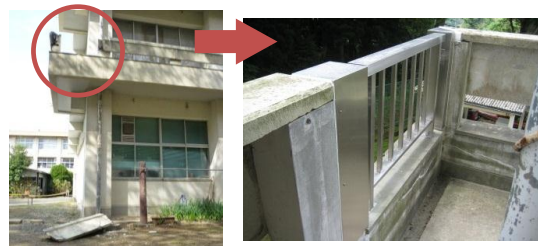
老朽化したバルコニーの手すりを改修 〔茨城県立高萩高等学校〕
