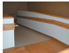
廊下と材質が異なり分かりやすいスロープ 〔京都府京都市立涉成小学校〕
