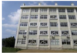
管理普通教室棟の耐震改修 工事を実施 〔新潟県立安塚高等学校〕
