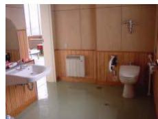
車いすで方向転換ができるスペースを確保したトイレ 〔秋田県鹿角市立北陽小学校〕
