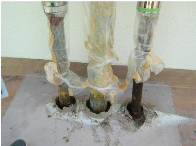
雨水の浸食により消防用鋼管が腐食
