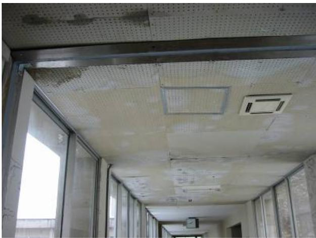
雨漏りにより天井が劣化(築31年)
