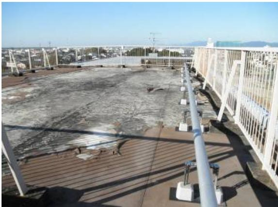
防水層の劣化。内部では雨漏りが発生し、
