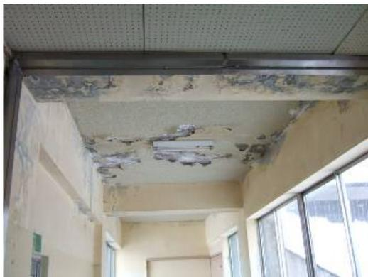
雨漏りにより天井が劣化(築38年)
