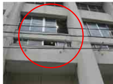
障子の落下箇所
