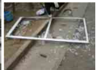
落下して破損した障子
