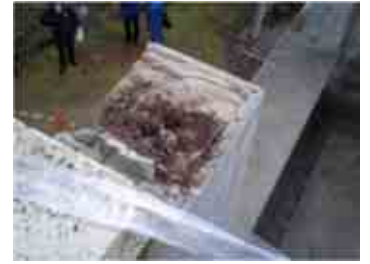
手すりの接合部 (支持部)
