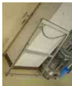
落下した障子
