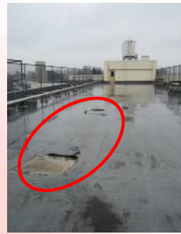
屋上防水の老朽化で 頻発する雨漏り
