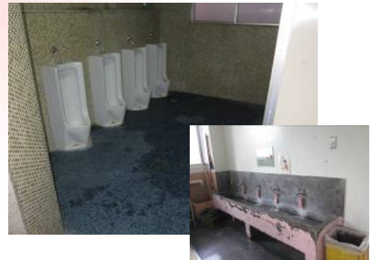
トイレの老朽化による臭気
