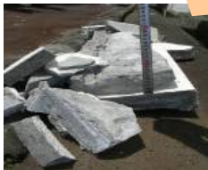
老朽化により モルタルが落下
