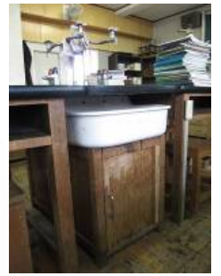
度重なる配管の破損
