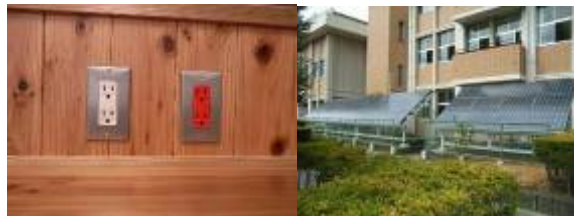
太陽光発電コンセント(赤) (今町小) / グラウンドから見える太陽光発電設備 (南越小)
