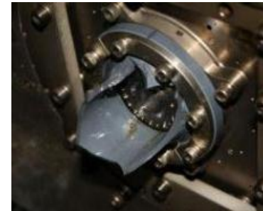
再着火後に破損が進行した燃焼器
