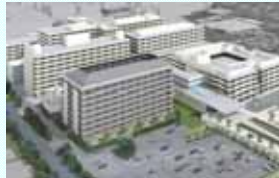
京都大学 医学部附属病院 積貞棟
