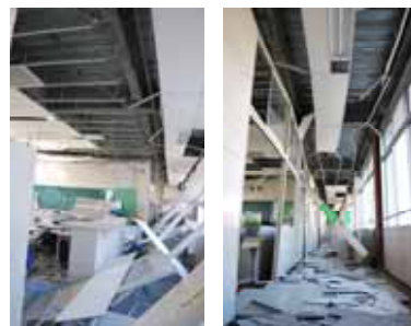
茨城大学 (天井材の落下等)
