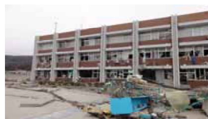
東京大学 (津波による建物等の損壊)
