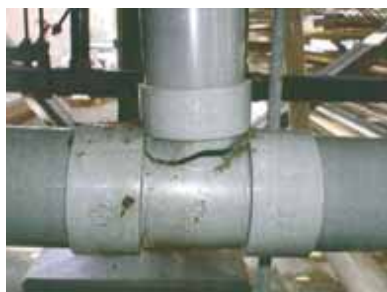
筑波大学 (排水管の破損)
