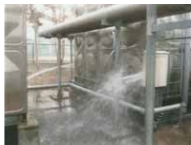
高エネルギー加速器研究機構 (受水槽の破損)
