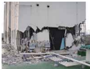
東北大学 (塔屋外壁の破壊)
