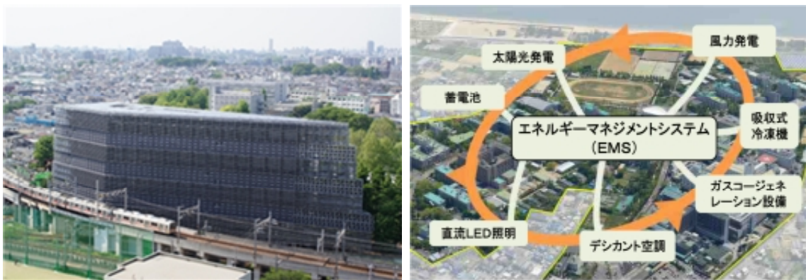
環境エネルギーイノベーション棟（東京工業大学） スマートキャンパス（三重大学）
