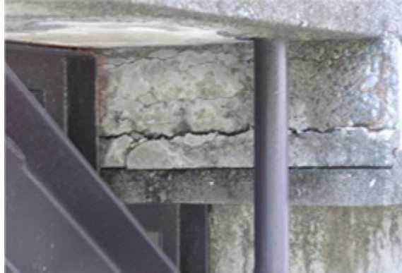
校舎外壁等の老朽化の状況（校舎外壁タイルの浮きやひび割れ（左）、外部階段のひび割れ（右））
