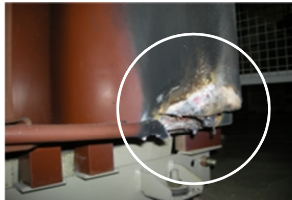
基幹設備（ライフライン）の老朽化の状況（給水管からの漏水（左）、変圧器の発火による損傷（右））
