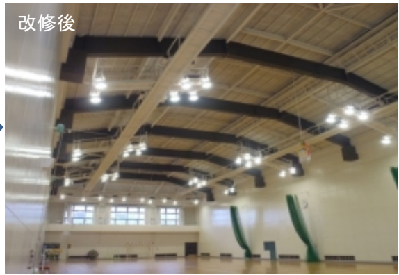
図表 2 0 非構造部材の耐震対策（天井材の撤去）
