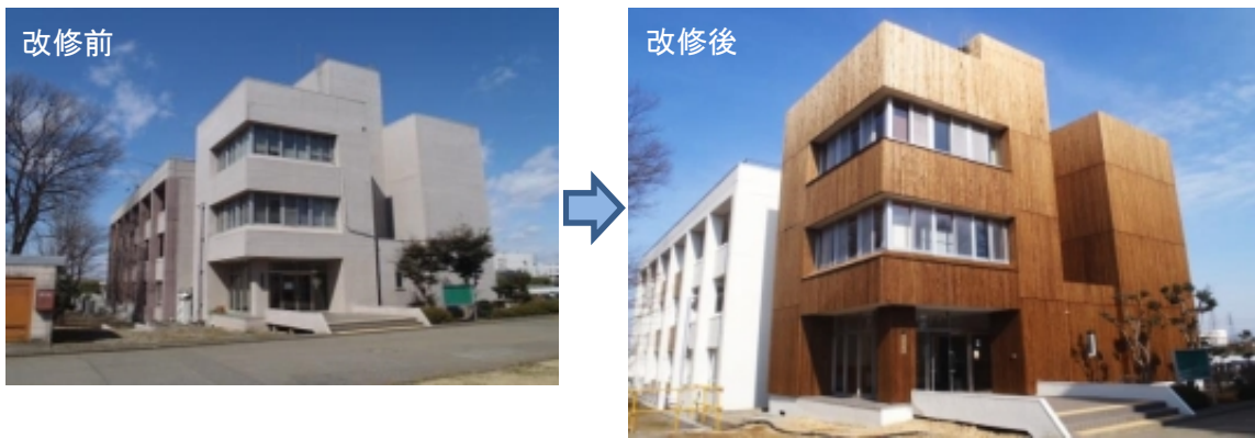
小山工業高等専門学校建築学科棟（地元産木材を校舎外壁に活用するほか、木材の断熱効果検証等の実験棟としても機能）
