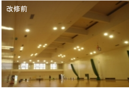
図表 2 0 非構造部材の耐震対策（天井材の撤去）
