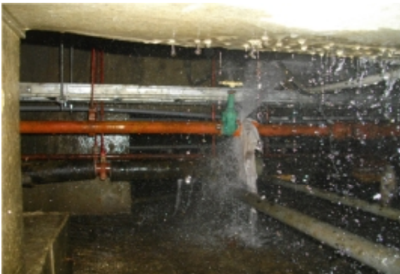
基幹設備（ライフライン）の老朽化の状況（給水管からの漏水（左）、変圧器の発火による損傷（右））
