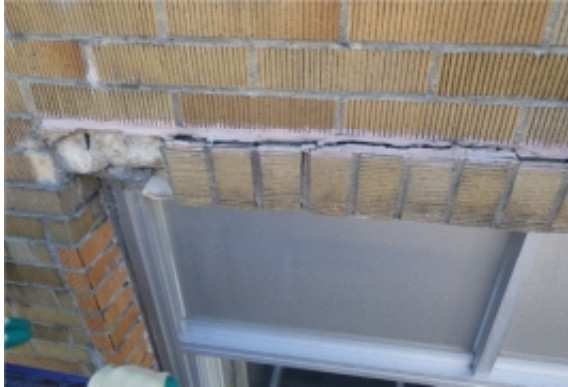
校舎外壁等の老朽化の状況（校舎外壁タイルの浮きやひび割れ（左）、外部階段のひび割れ（右））
