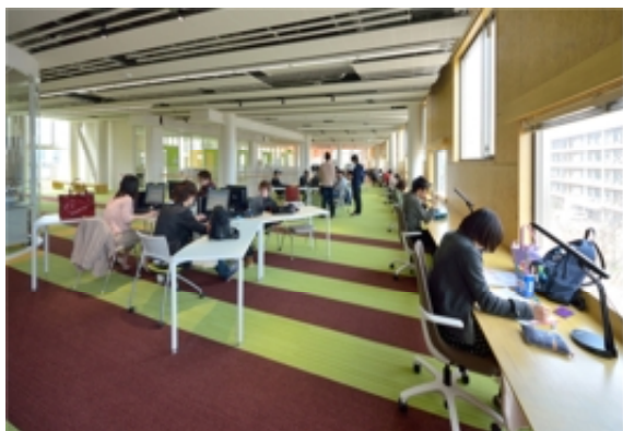
新潟大学中央図書館（既存図書館の改修に合わせてラーニング・コモンズを増築）
