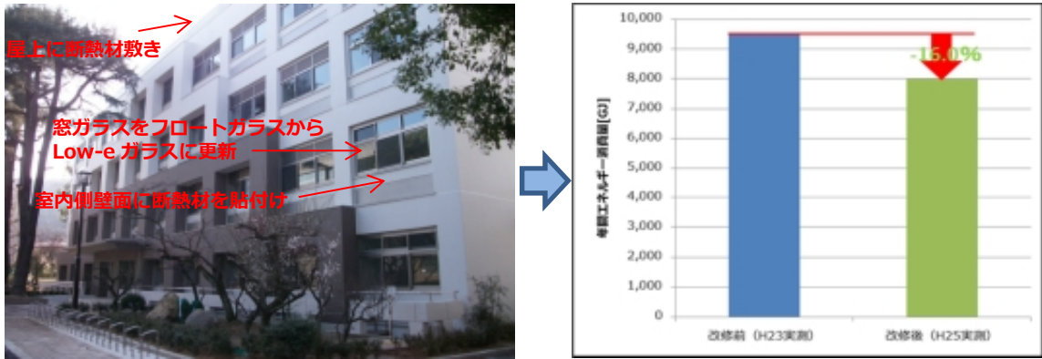
京都大学総合研究7号館（施設の耐震補強に合わせ、断熱性能の向上や設備の高効率化等を図る）
