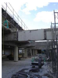
ひかりのみち部分 解体状況
