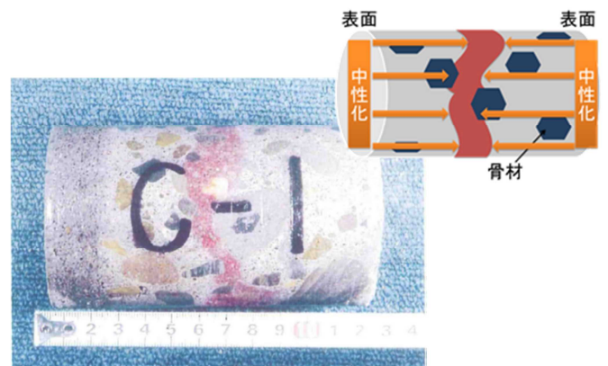
図2 改修前のコンクリートに試薬を噴霧した状況 (アルカリ性の部分が赤くなる。中性化が著しい。)
