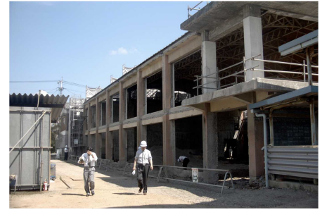
図4 改修中の風景
