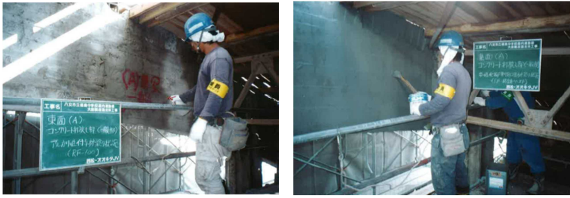
図3 中性化対策（左：アルカリ性付与材塗布 右：中性化抑制材塗布）
