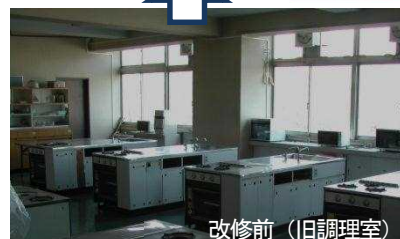
改修前（旧調理室）
