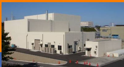
ニュートリノ 第2設備棟
