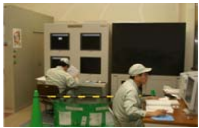
総合漏えい監視盤
