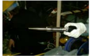
配管取付け直前の改良型温度計
