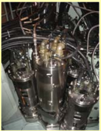
制御棒駆動機構(炉上部)
