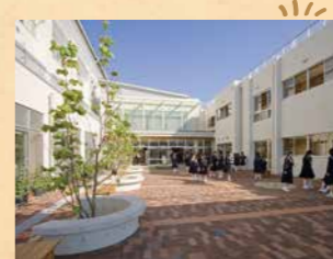
学校施設の長寿命化改修
