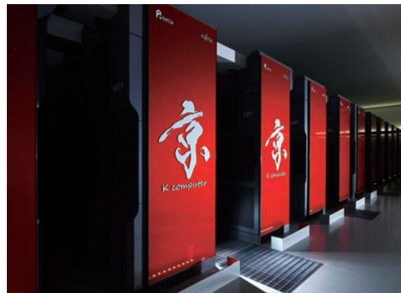
特定高速電子計算機施設 スーパーコンピュータ「京」 (理化学研究所:兵庫県神戸市) 提供:理化学研究所
