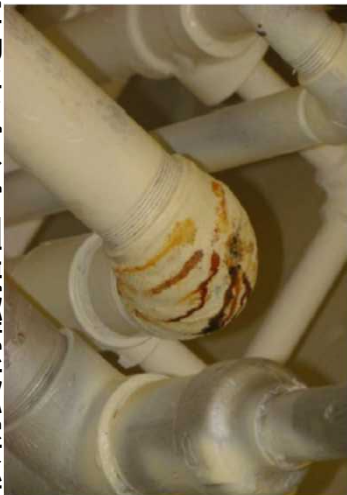
高経年化対策 アスファルト固化処理施設浄水配管の更新 (核燃料サイクル工学研究所)
