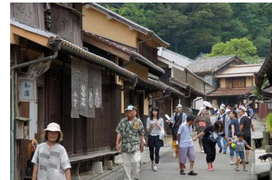
<観光客の賑わう伝統的建造物群> 大田市大森銀山伝統的建造物群保存地区 (島根県大田市)
