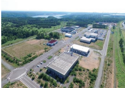
国際核融合エネルギー研究センター（青森県六ヶ所村） 提供：量子科学技術研究開発機構
